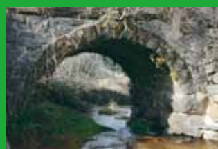
『電ノ氏橋』は舗装されて一部補修の跡もあって、現在も使用されている。
