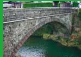
佐々川本流、県道菰田線に架かる世知原で一番大きな『倉淵橋』。大正七年架橋で、長さ20.6m、幅4.6m、橋高8.1m。
