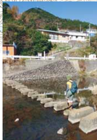
相浦川に渡る飛び石。砂岩に木材を通してある。向こうに愛宕山が見える。
